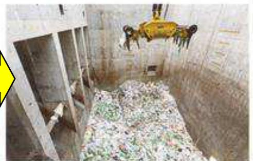
ごみピットに集められます。大きなクレーンでかき混ぜることで、空気を含ませて燃えやすくしたり、均一に燃えるようにしたりします。
